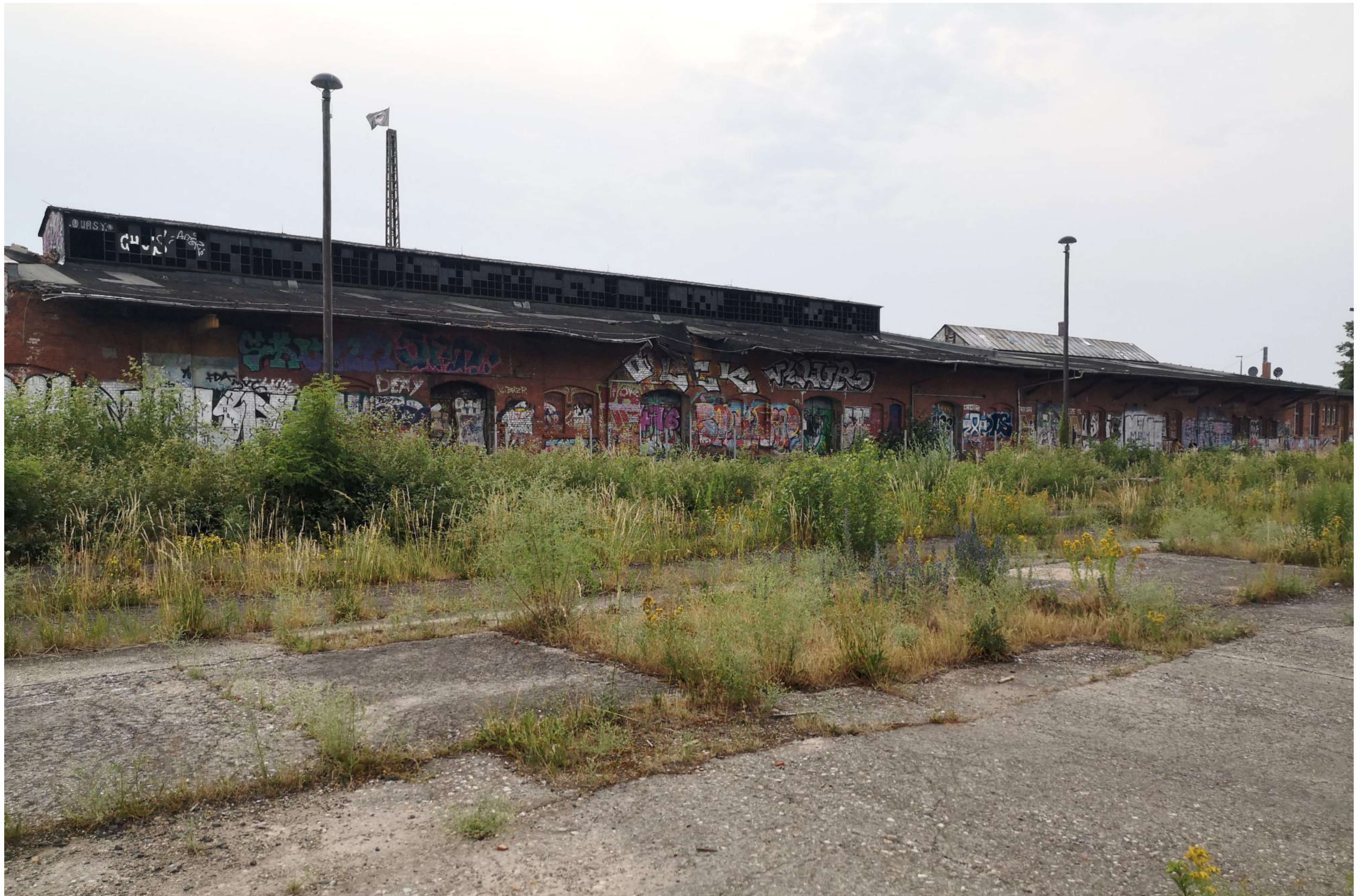
Vor Ort Aufnahme - Quelle: https://bahnhof-plagwitz.de/wp-content/uploads/2023/12/vegetation-platte-westbahnhof-jun23.cleaned.jpg
