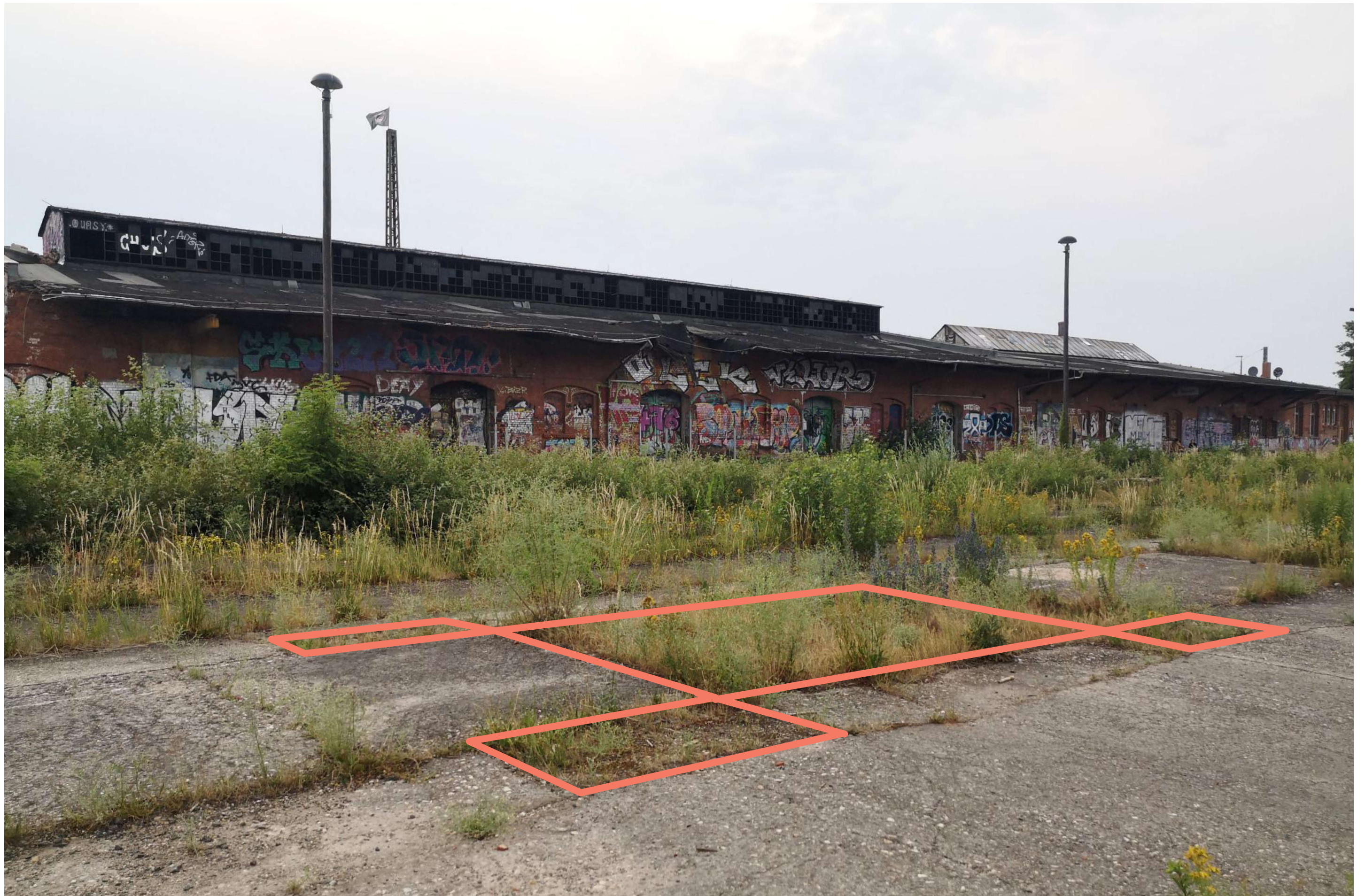
Vor Ort Aufnahme - Quelle: https://bahnhof-plagwitz.de/wp-content/uploads/2023/12/vegetation-platte-westbahnhof-jun23.cleaned.jpg
